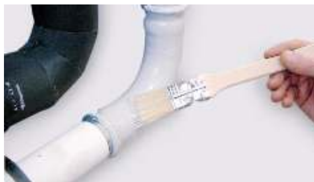
Рис. 37. Покраска соединений и труб праймером.
