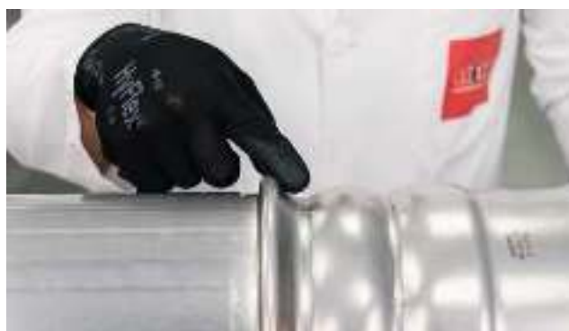
Рис. 36. Визуальный осмотр места прессования Oversize.
